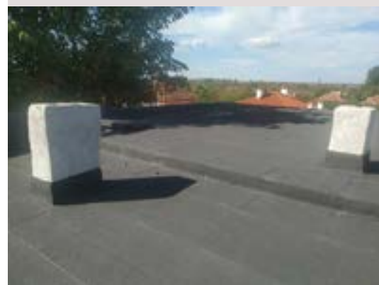
Покривът на кметството след ремонта
