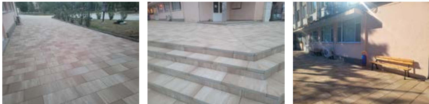
Ремонтираният площад пред кметството
