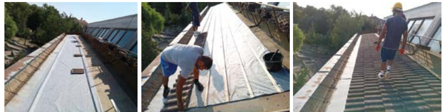
Ремонт на покрива на НЧ „Развитие 1892“ в гр. Бяла Слатина
