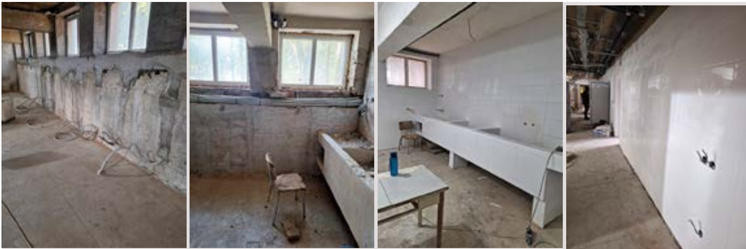
Кухнята в МБАЛ Бяла Слатина по време на ремонтните дейности
