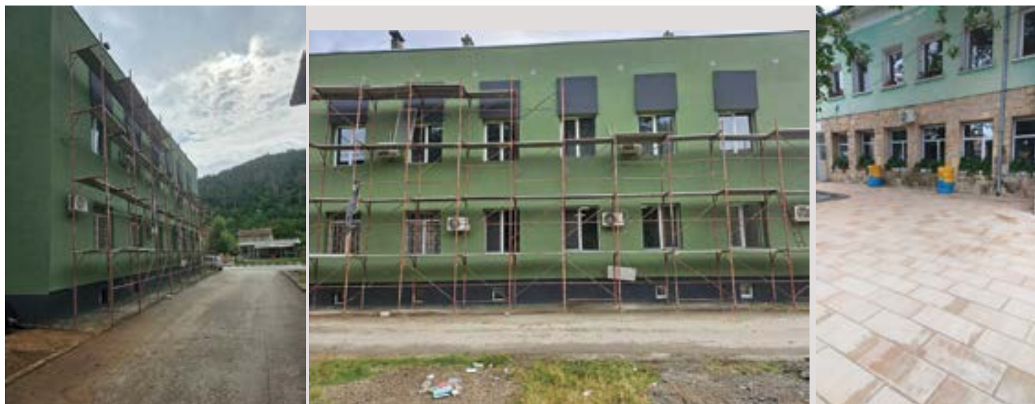
Сградата на кметство Габаре по време на ремонта
