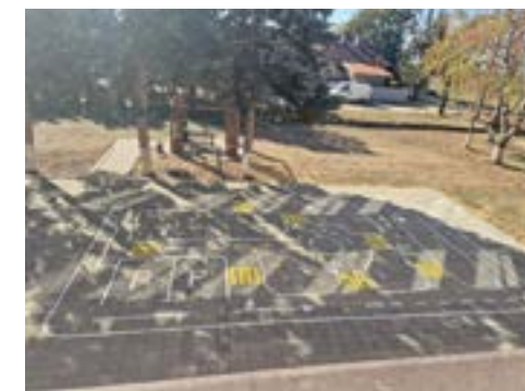
Външна площадка по БДП в ПГО „Елисавета Багряна“
