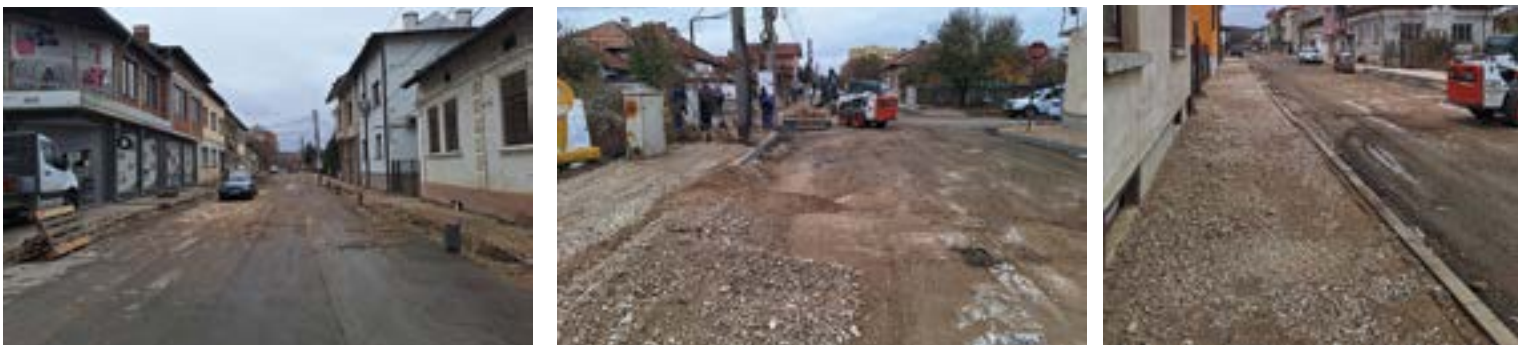
Ул. „Хан Крум“ - в участъка от ул. „Васил Левски“ до ул. „Крайбрежна“ по време на ремонта
