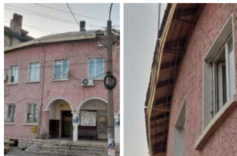
Ремонт на покривната конструкция на кметство Тлачене
