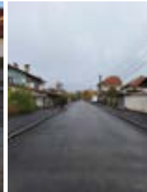
Ул. „Дунав“ след ремонтните дейности
