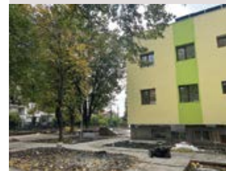
Външен ремонт на ДГ „Детелина“
