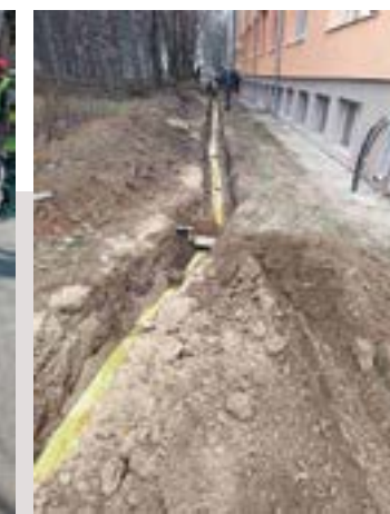
Изграждане на ел. захранване за кухненски блок в ОП „Пазари и социални дейности“
