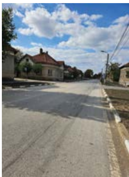
Ремонт на ул. „Георги Димитров“
