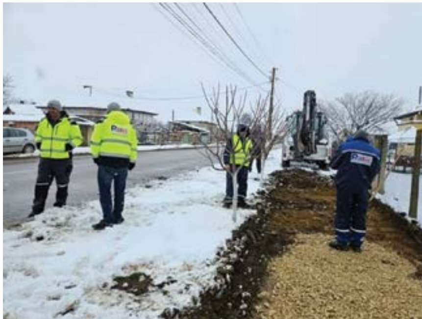
Ремонт на тротоари
