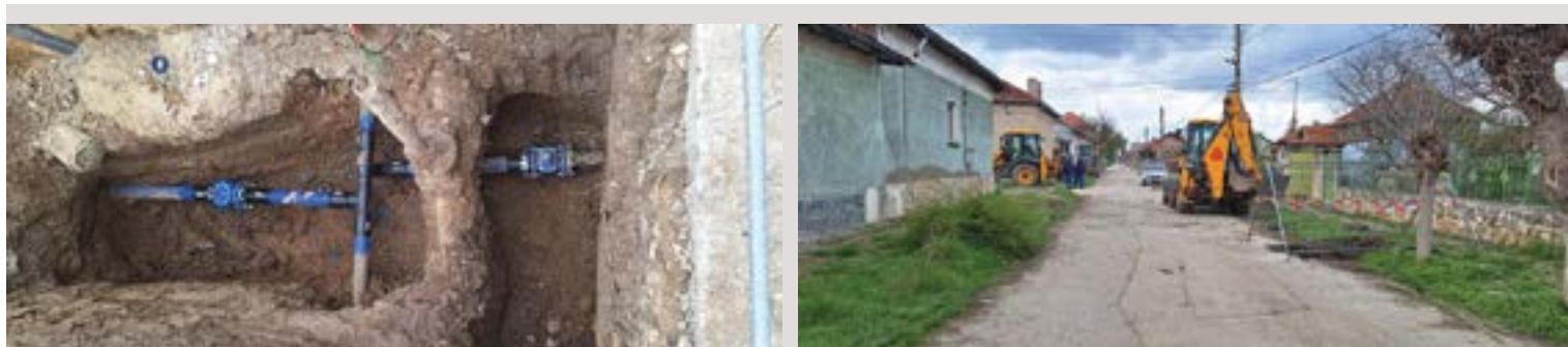
Реконструкция на водопроводна мрежа
