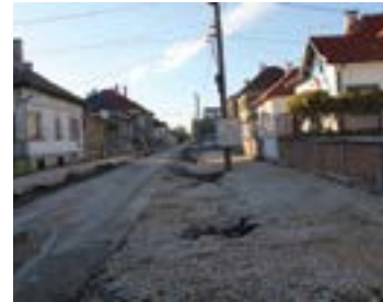
Ул. „Цар Симеон“ по време на ремонтните дейности
