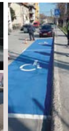
Изпълнение на пътна маркировка
