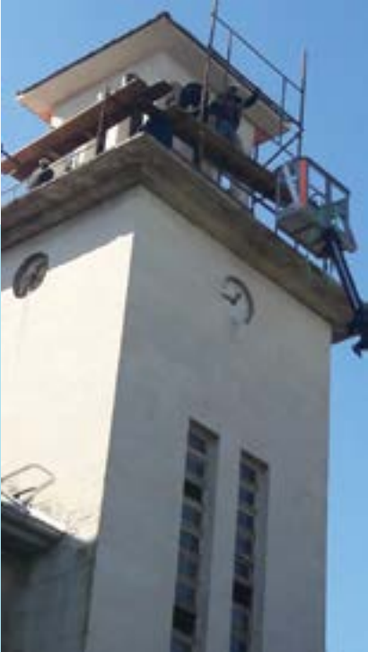
Ремонт на часовниковата кула
