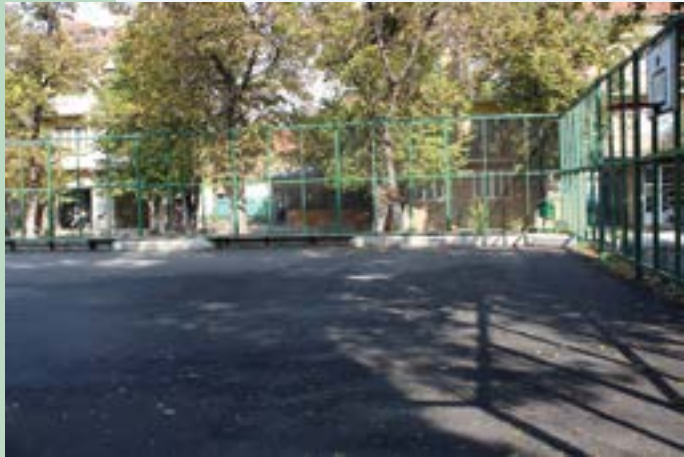
Спортна площадка при ОУ „Климент Охридски“ - след ремонта
