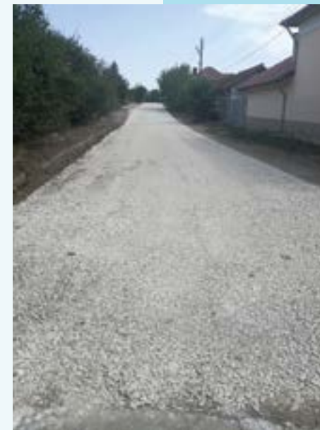
Положена трошено-каменна настилка
