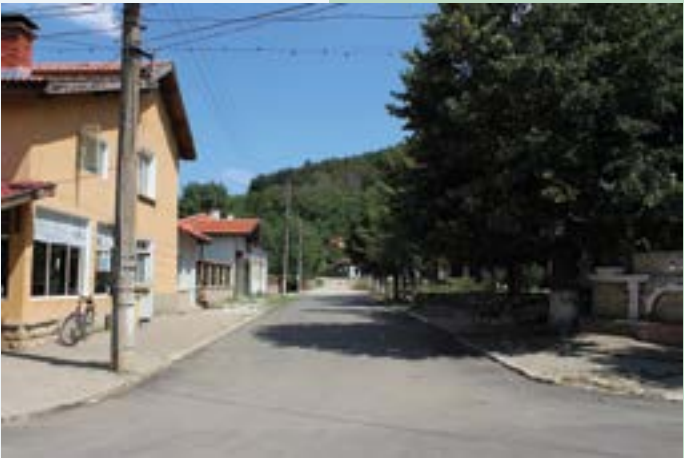
Ул. „Безименна“ след ремонта
