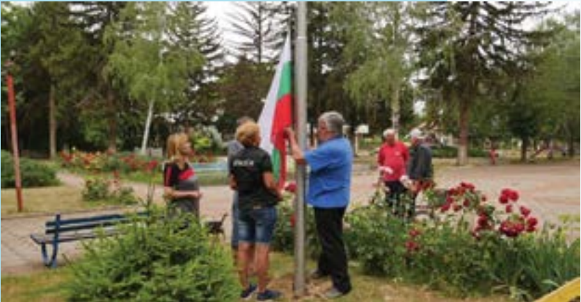
Монтиране на пилон в парка
