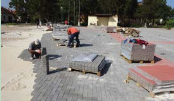
Площадът в с. Попица - по време на ремонтните дейности
