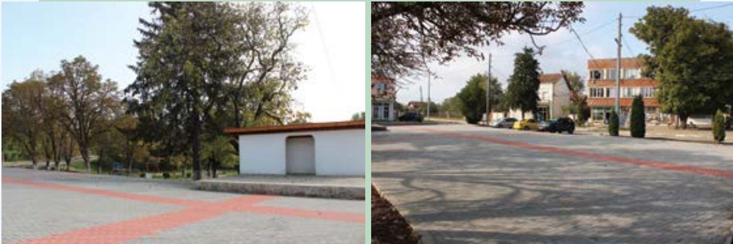
Площадът в с. Търнак - след ремонта
