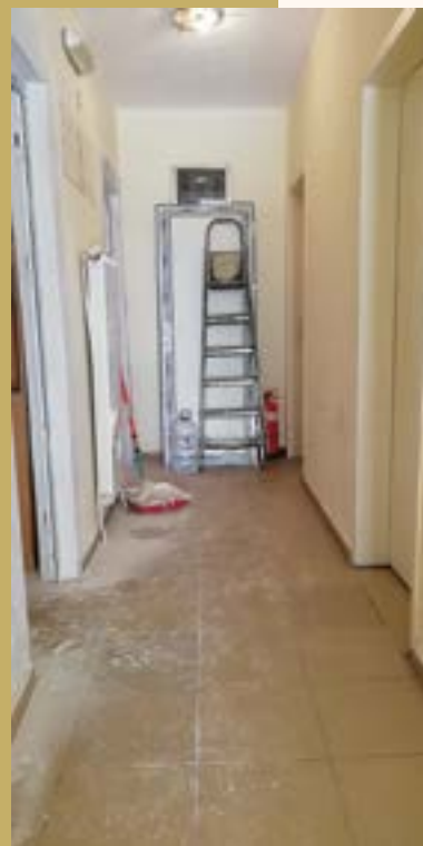
Ремонт на спалните помещения в ПЖ
