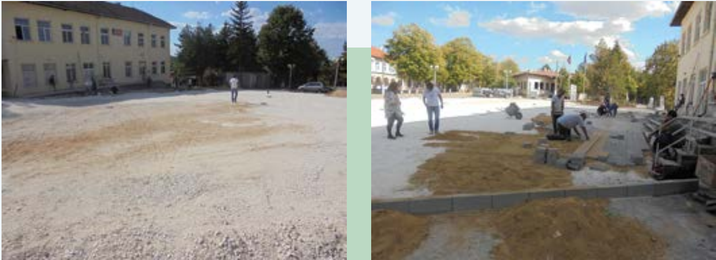
Площадът в с. Буковец - по време на ремонта
