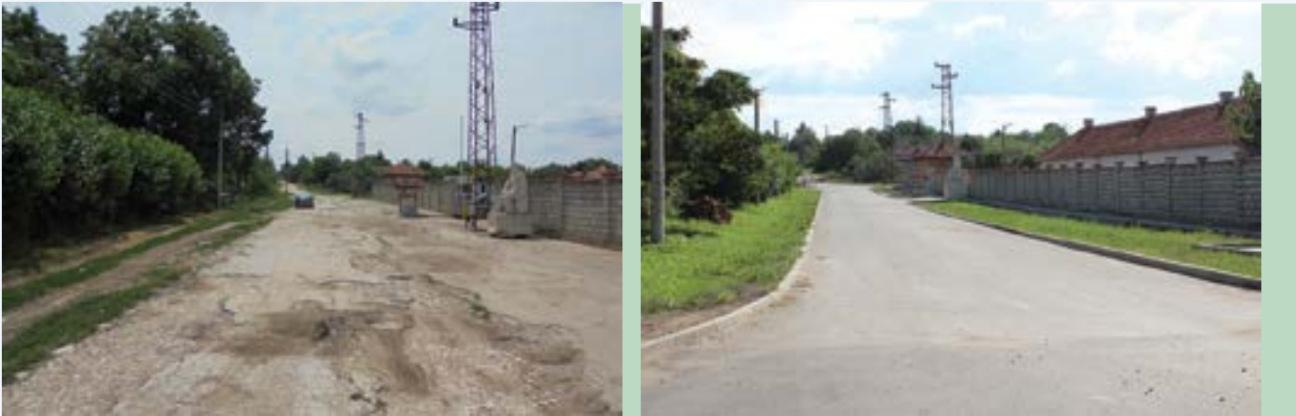
Ул. „Цар Симеон“ преди и след ремонта
