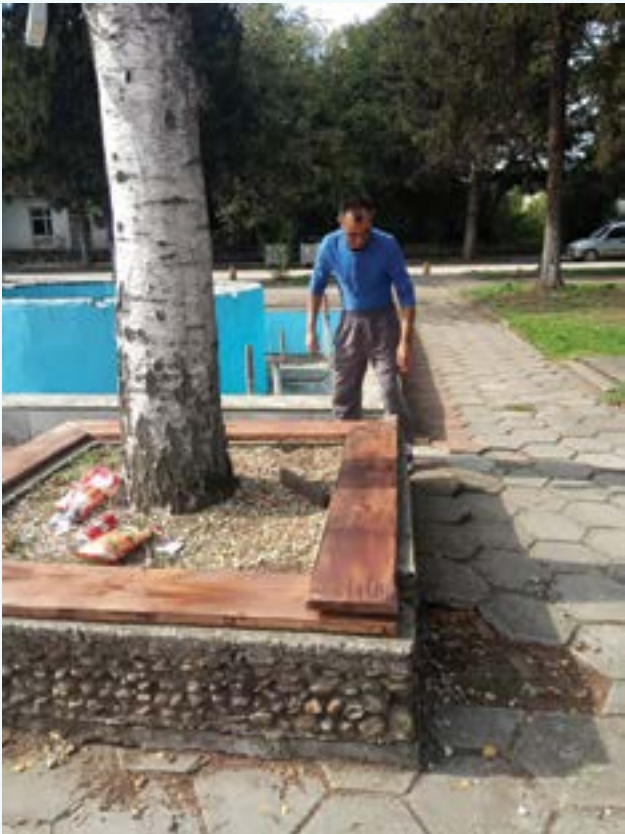
Монтиране на пейки
