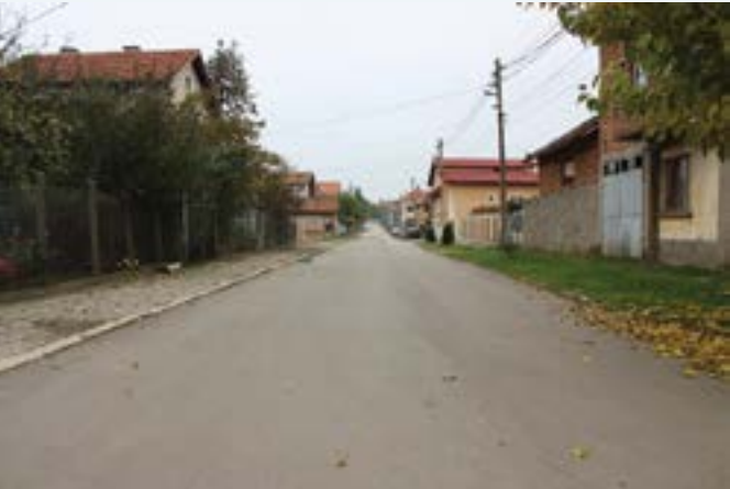
Ул.„Панайот Волов“ след ремонта
