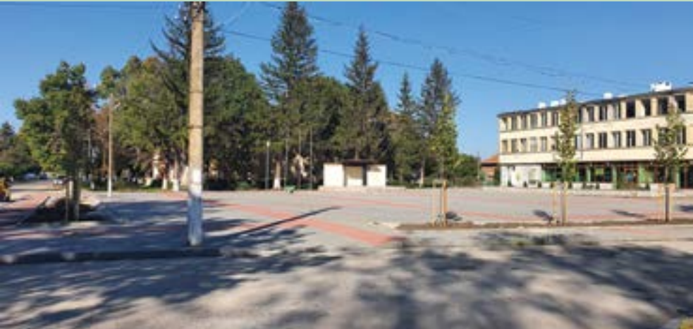
Площадът в с. Попица - след основен ремонт
