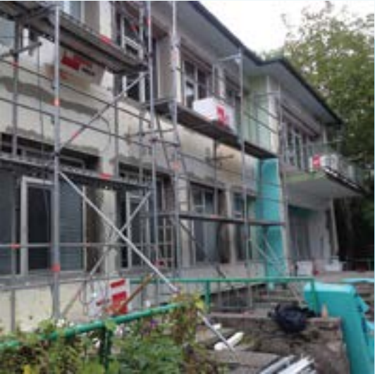
Ремонт на детската градина
