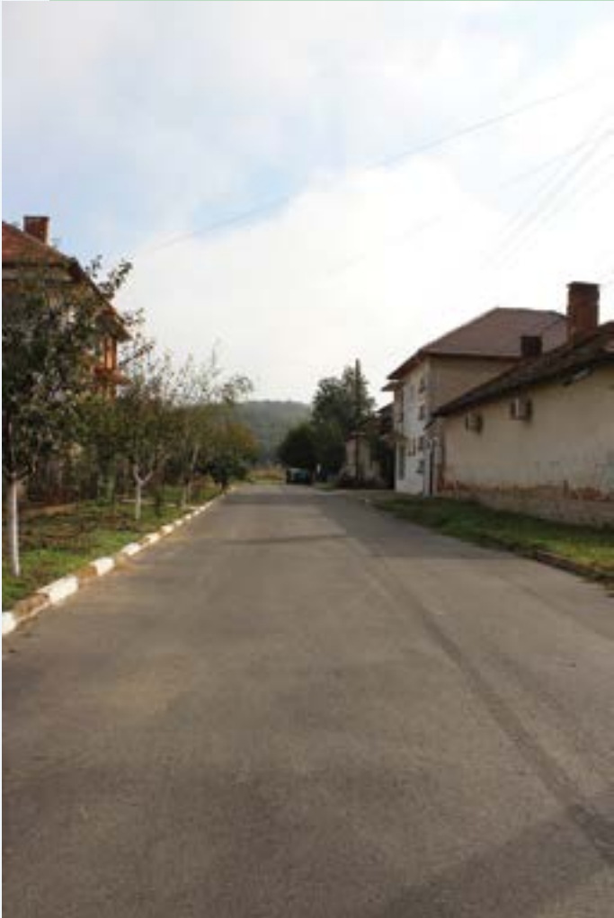
Ул. „Сладница“ - след ремонта
