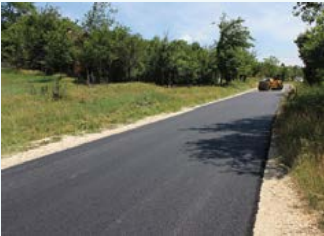
Ремонт на ул. „Коста Златарев“
