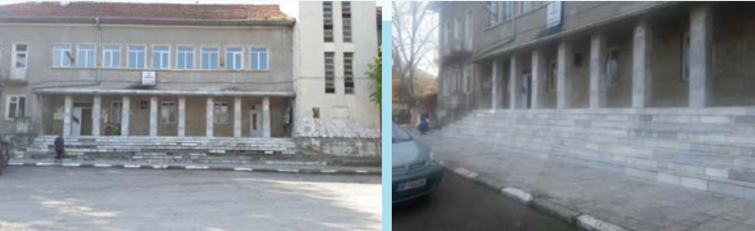
Стълбището пред кметството - преди и след ремонта
