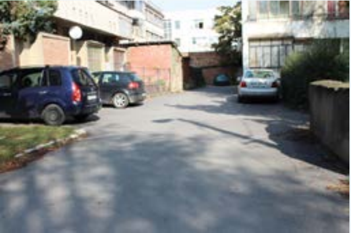
Улица при жил. блок „9-ти септември“ - след ремонта
