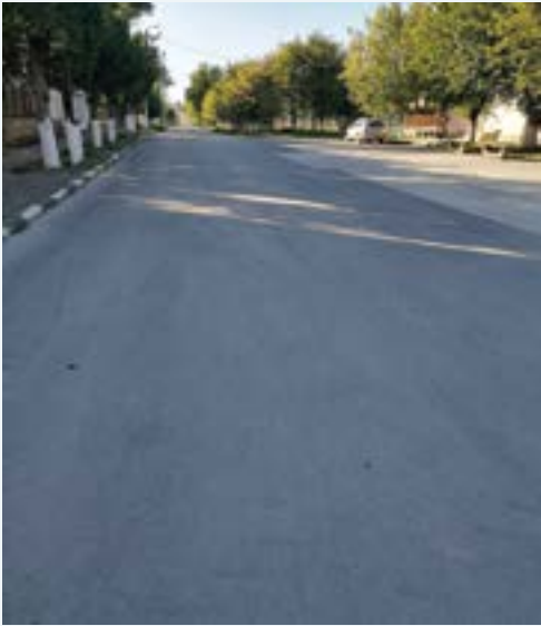
Ул. „Христо Ботев“ пред кметството - след ремонта
