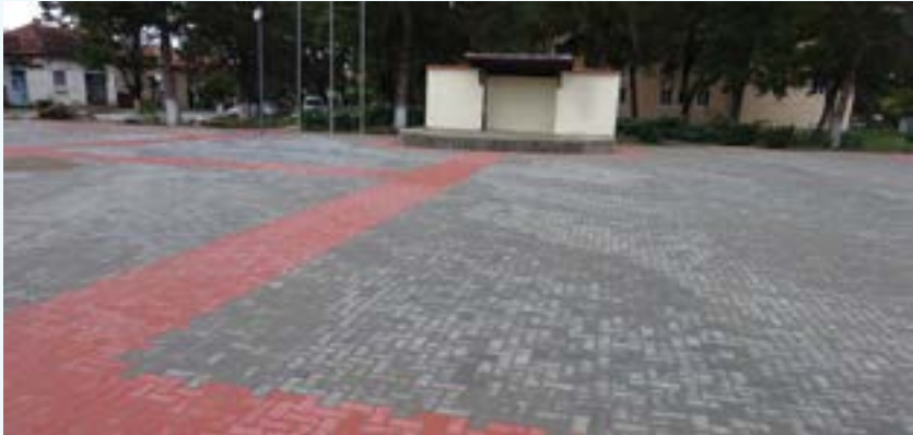
Площадът след ремонта
