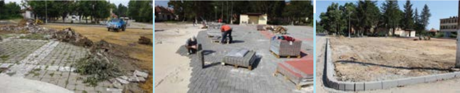
Ремонтни дейности на площада
