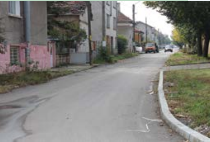
Ул.„Любомир“ след ремонта
